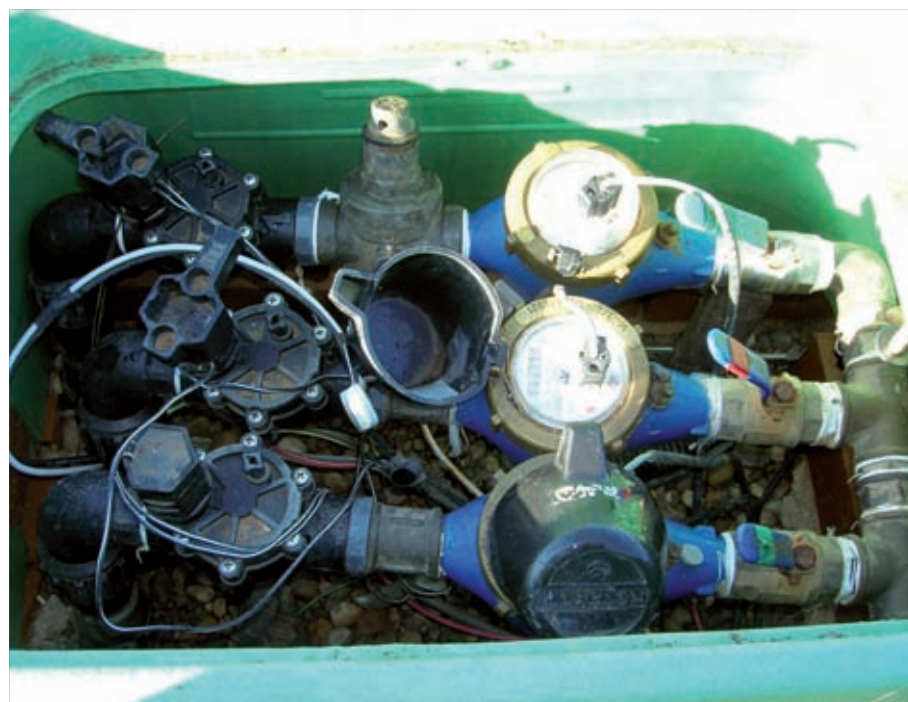
Figura U. Contador de agua y electroválvula
