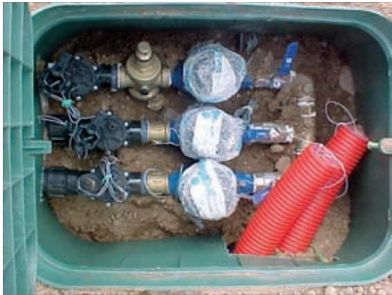
Figura 27. Imagen de una arqueta tras la colocación
