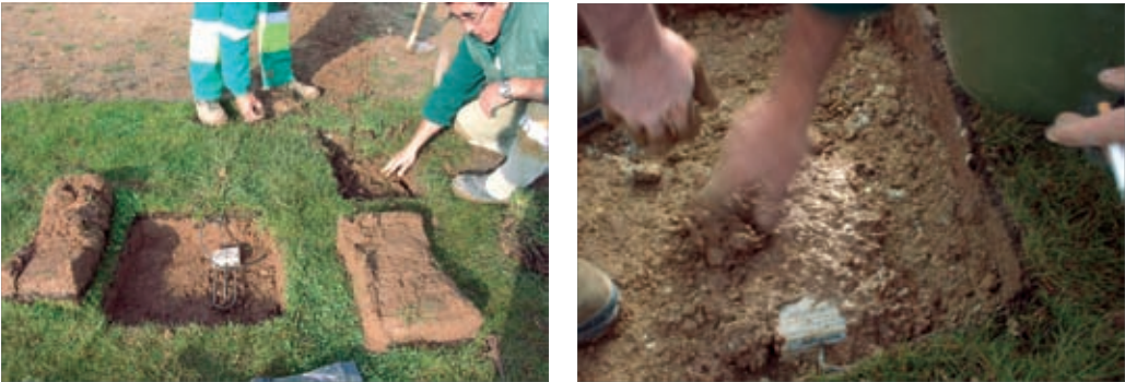
Figura 26. Instalación de sensor de humedad
