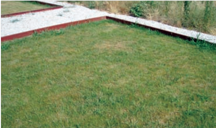
Figura 21. Césped con goteo enterrado
