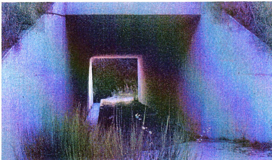
Foto 7: Paso inferior para pequeños vertebrados de 2 x 2 metros
