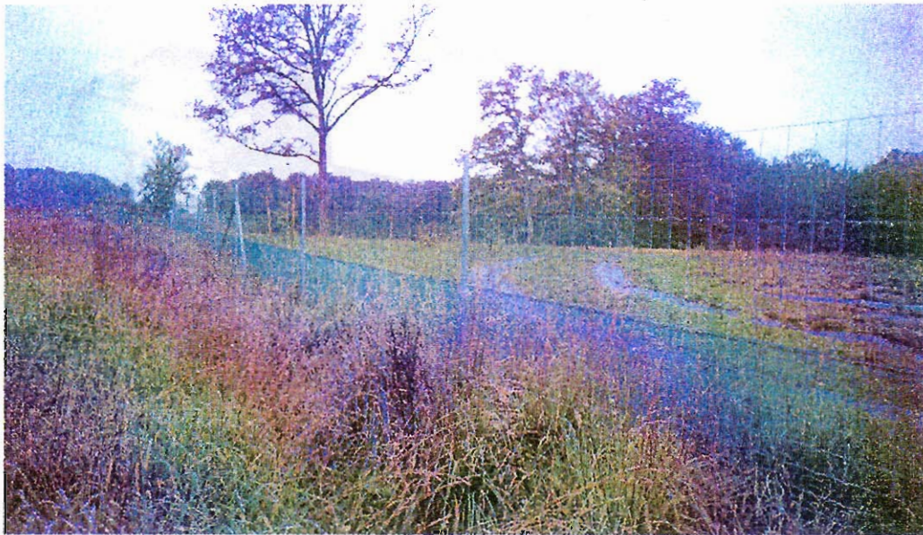
Foto 1: Ejemplo de vallado perimetral con refuerzo inferior para evitar el paso de pequeños animales.
