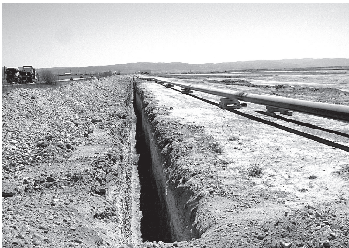
Trabajos de construcción de un gasoducto que atraviesa la plataforma logística Platea. ANTONIO GARCÍA
