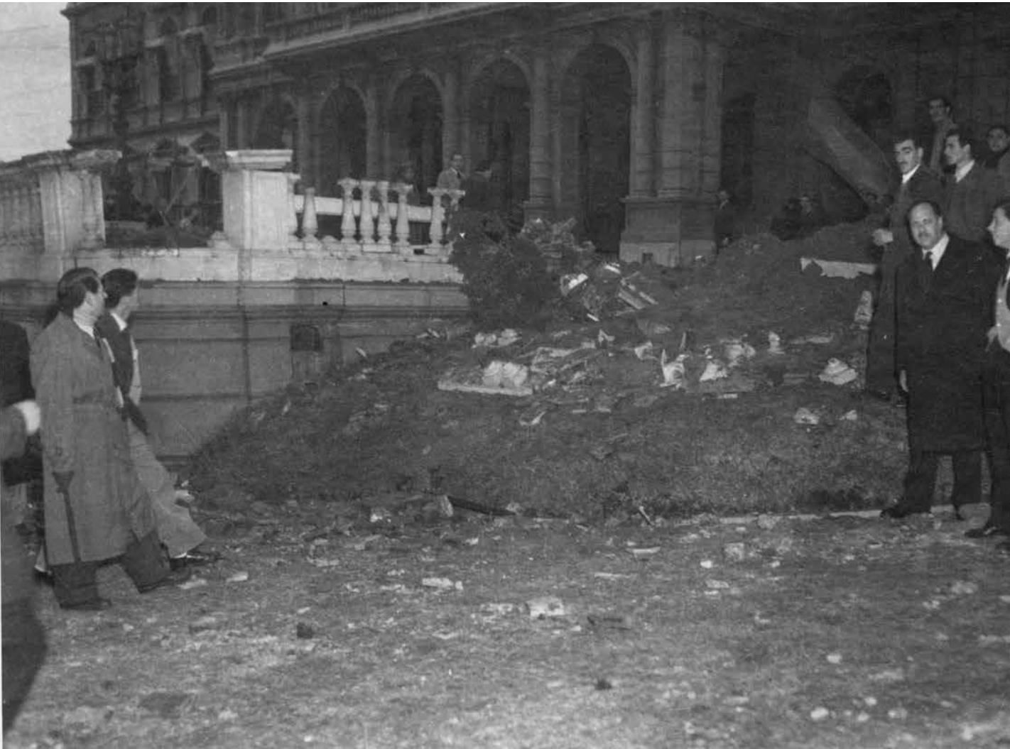
Destrozos producidos por las bombas en la Casa de Gobierno. Junio de 1955 Fotografía: Archivo General de la Nación
