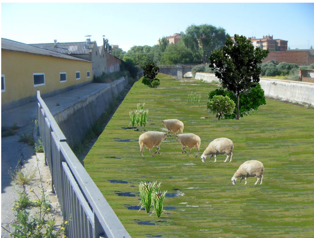
Simulación nº 2.2. Eliminación de la solera de hormigón en tramo urbano, aguas abajo del puente del ferrocarril. Revegetaciones y manejo de pastizal.
