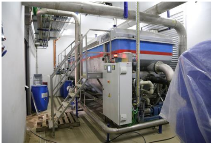
Imagen 12 Imagen unidad de flotación DAF
