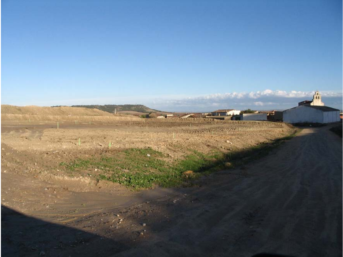
Fotografía 1. Movimientos de tierra en la zona del aparcamiento proyectado.
