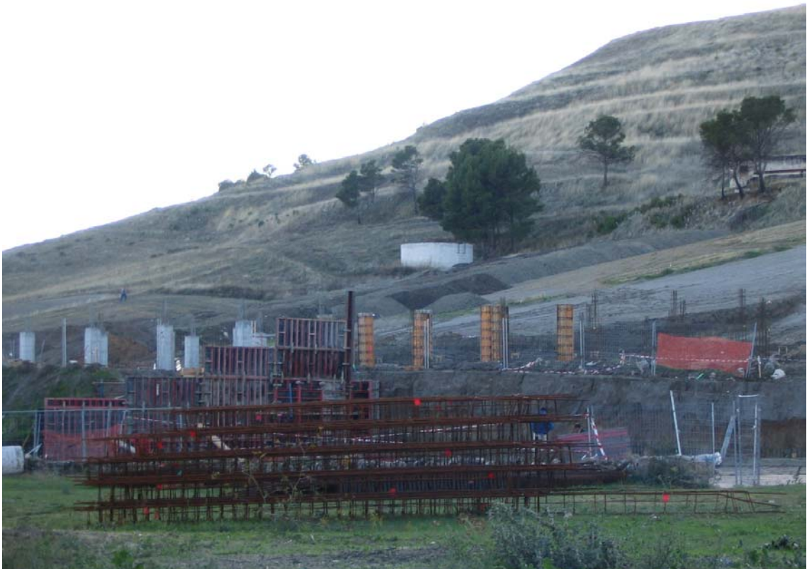
Fotografía 2. Obras de construcción de las edificaciones proyectadas y pista de esquí
