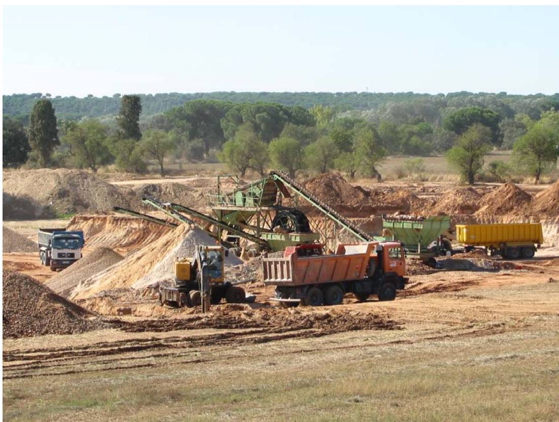
Fotografía 4. El Pesquerón . Excavaciones de Hormigones Hegeo S.A. en octubre de 2003. Detalle de las operaciones de carga de grava en los camiones denunciados
