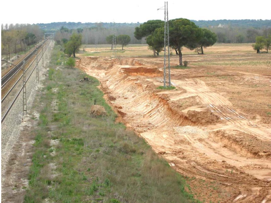
Fotografía 1. El Pesquerón . Excavaciones de Hormigones Hegeo S.A. en abril de 2002, junto a la vía de ferrocarril Valladolid-Madrid
