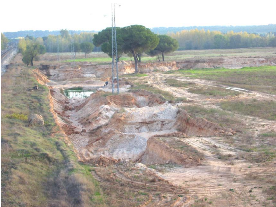
Fotografía 2. El Pesquerón . Excavaciones de Hormigones Hegeo S.A. en octubre de 2002. Se observa la progresión de la excavación y la afección al nivel freático
