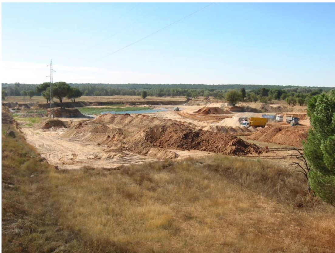
Fotografía 3. El Pesquerón . Excavaciones de Hormigones Hegeo S.A. en octubre de 2003. Se observa la aceleración de la excavación y la actuación de varios camiones en la misma
