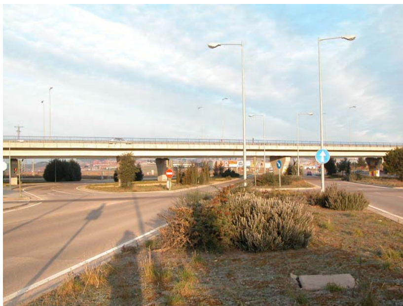
Las rotondas bajo viaducto abren las perspectivas y procuran más visibilidad para los conductores...
