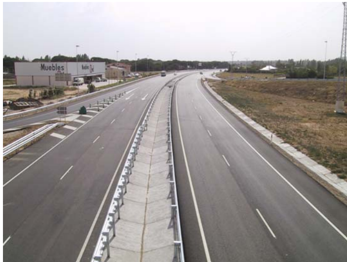
Aspecto desolador que presentan las medianas hormigonadas
