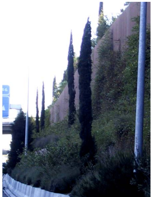
Tratamiento blando de los muros de contención M-40. Madrid
