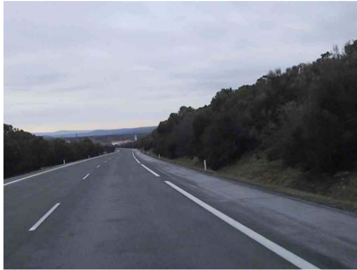
Vallados cubiertos de vegetación en la A-6
