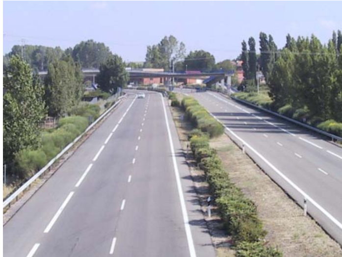
Autovía sin cunetas hormigonadas donde la vegetación agarra más fácilmente
