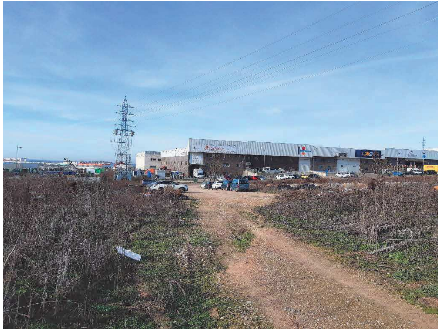
Sector de construcción parking en acceso calle Helio
