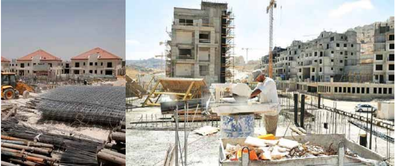
أعمال بناء في إحدى المستوطنات في الضفة الغربية
