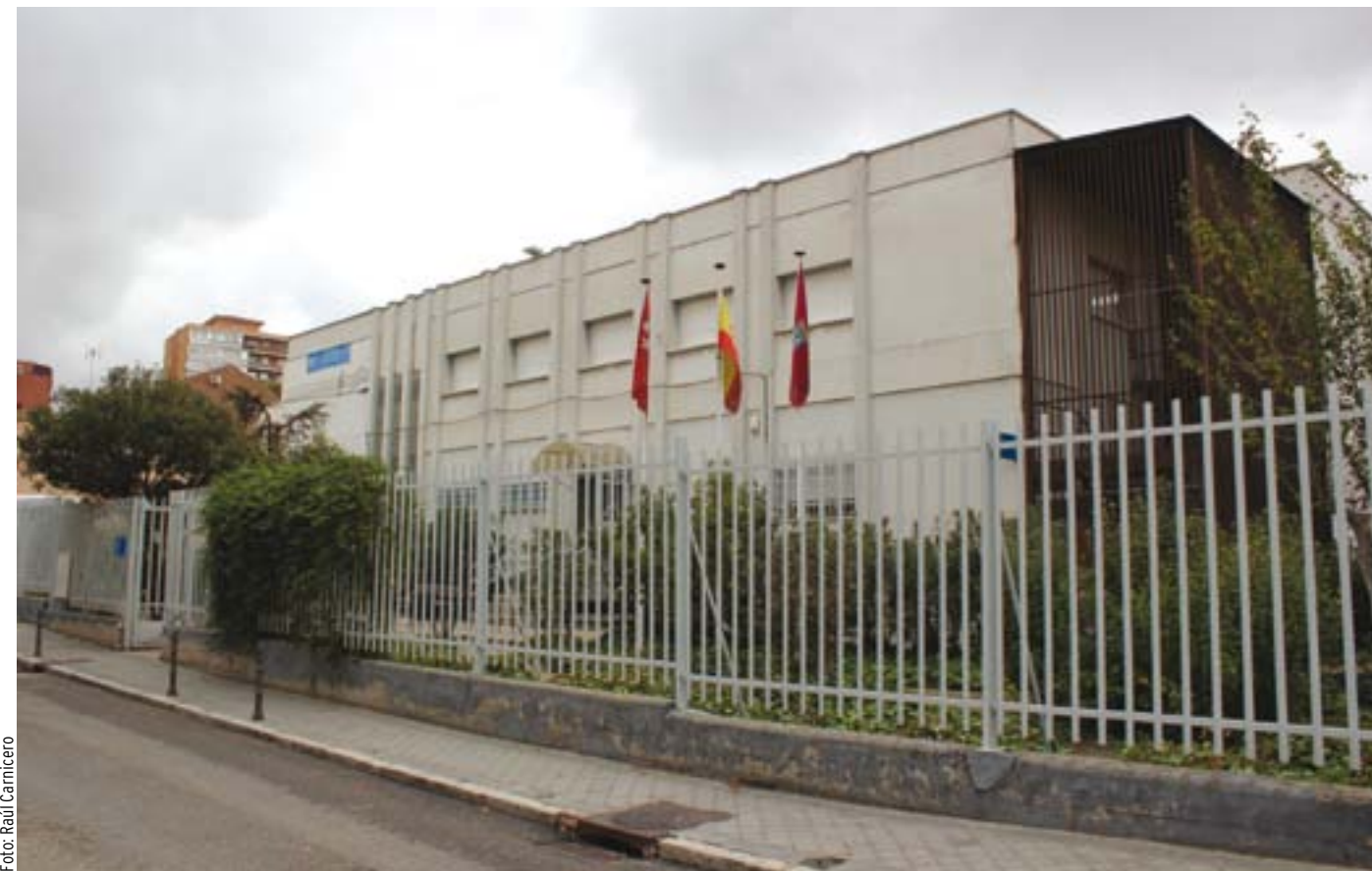
El Centro Cultural Federico Chueca se encuentra en la calle Benita de Ávila, en el barrio de Canillas.
