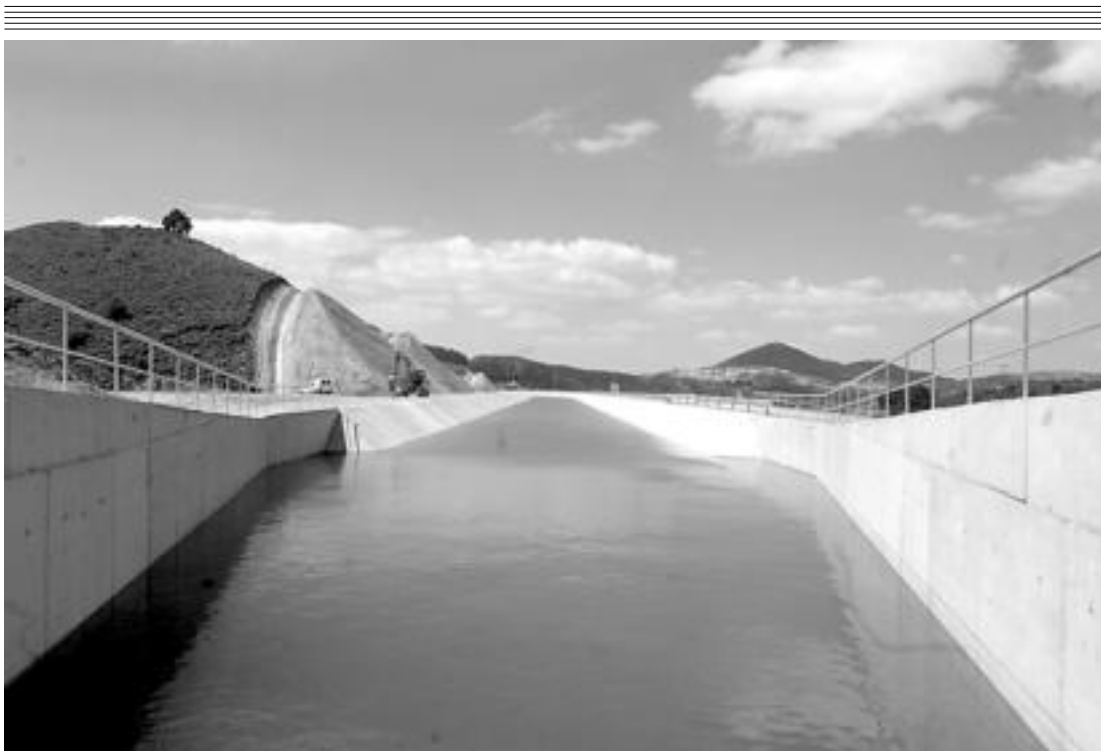
Segundo bakoitzeko 1.015 litro ur jasotzeko gaitasuna du Arrizabalagako tunelaren ondoren jarritako harguneak. LANDER F. ARROIAIBE / ARCAZKI PRESS
