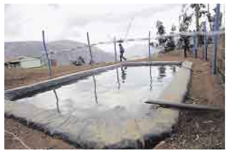
RESERVORIOS. Se construyen con materiales naturales y están conectados a mangueras con aspersores que pueden regar un cuarto de hectárea.
