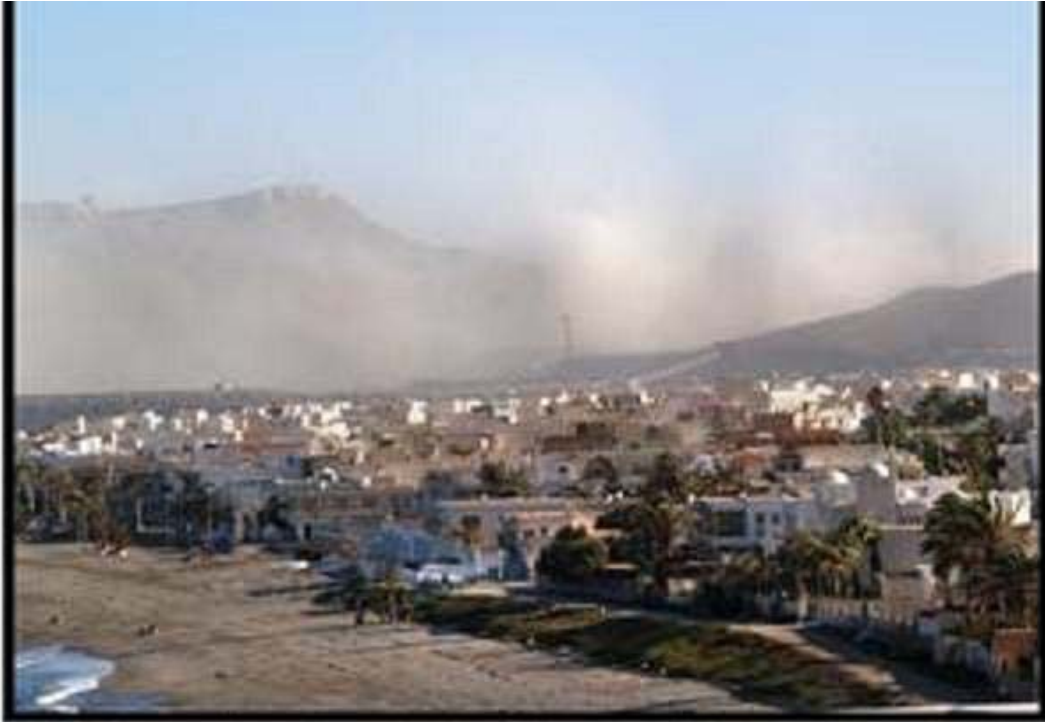
En primer termino nucleo urbano de Carboneras, al fondo: puertos y poligono industrial, Endesa y Holcim a la dcha. de imagen
